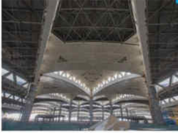
أعمال ترميم الأسقف الداخلية
